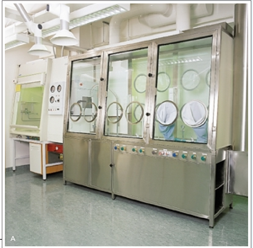
A. Handskbox för beredning av läkemedel under sterila förhållande, med krav på nollexponering av omgivningen.
